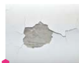
Rebouchage des trous et petites fissures
