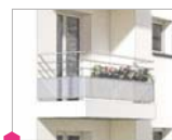
Si balcon, entretien de l'espace et débouchage de l'évacuation
