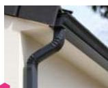
Nettoyage des gouttières accessibles
