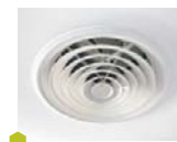
VMC Ventilation Mécanique Contrôlée
